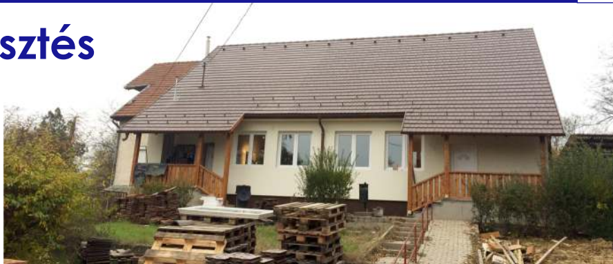
A Védőnői és Gyermekorvosi Rendelő épületének felújítása
